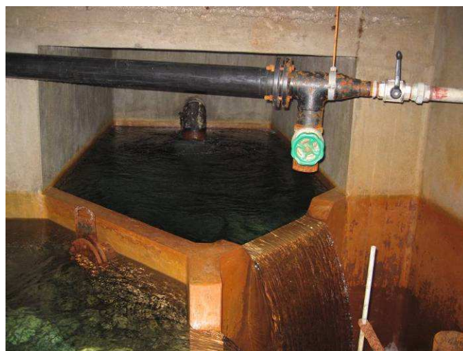
Figura 11 - Manufatto partitore - Particolare interno
