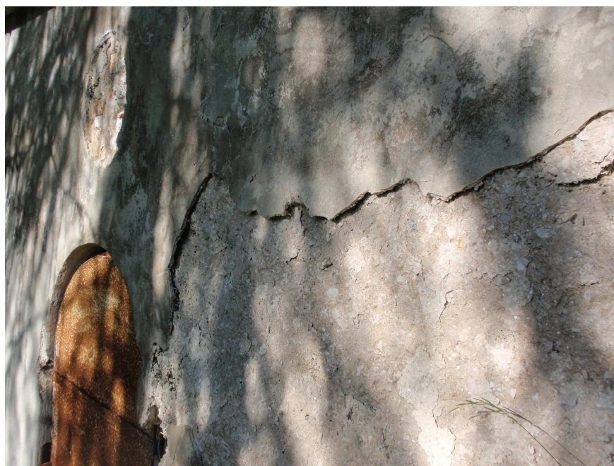
Figura 23 - Opera di accumulo B – particolare della facciata deteriorata
