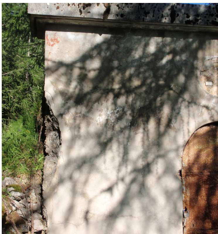
Figura 24 - Opera di accumulo B – particolare della facciata deteriorata
