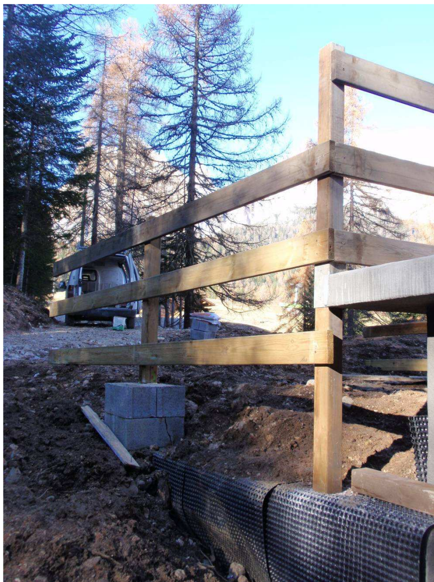
Figura 16: tipologia di parapetto in legno previsto in progetto – fase di posa
