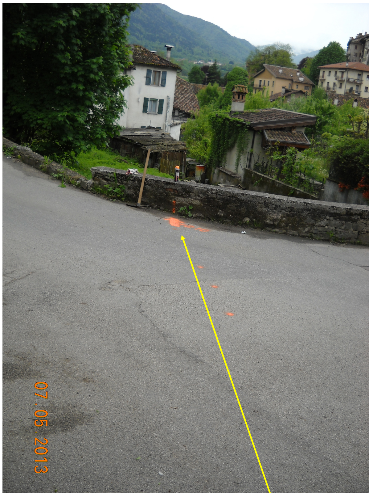
Foto 11: Particolare del punto di recapito condotta di scarico serbatoio (analogo all'attuale).
