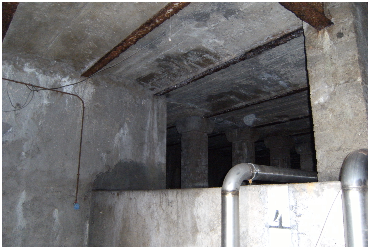
Foto 12: Particolare interno serbatoio – paramento da cui si accede alla vasca sul quale verrà installato nuovo parapetto di protezione anticaduta.
