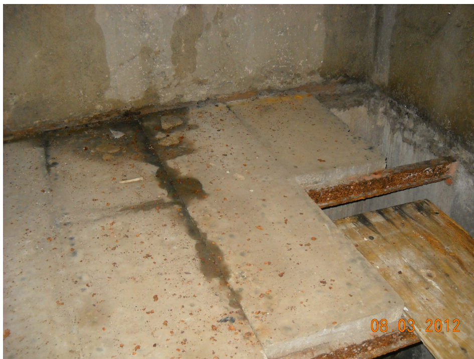
Foto 4: Interno serbatoio – particolare pianerottoli interni camera di manovra – lato sinistro entrando. Evidente lo stato di degrado delle piastre in calcestruzzo e delle travi di appoggio
