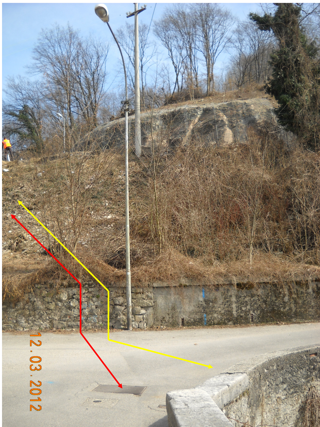
Foto 6-7-8-9-10: Particolari dello sviluppo progressivo schematico del tracciato delle nuove condotte da posare in partenza in prossimità del pozzetto in via Tortesen ed arrivo al serbatoio, sviluppandosi anche in attraversamento della strada comunale denominata "Panoramica"
