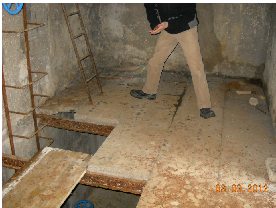
Foto 3: Interno serbatoio – particolare pianerottoli interni camera di manovra – lato destro entrando. Evidente lo stato di degrado delle piastre in calcestruzzo e delle travi di appoggio
