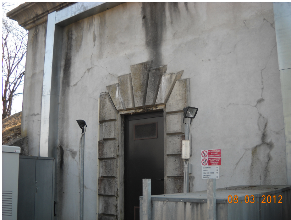
Foto 1: Esterno serbatoio – fronte nord-ovest – Ai lati della porta di accesso sono visibili gli armadi predisposti ed utilizzati per gli impianti di telefonia di proprietà “Vodafone”
